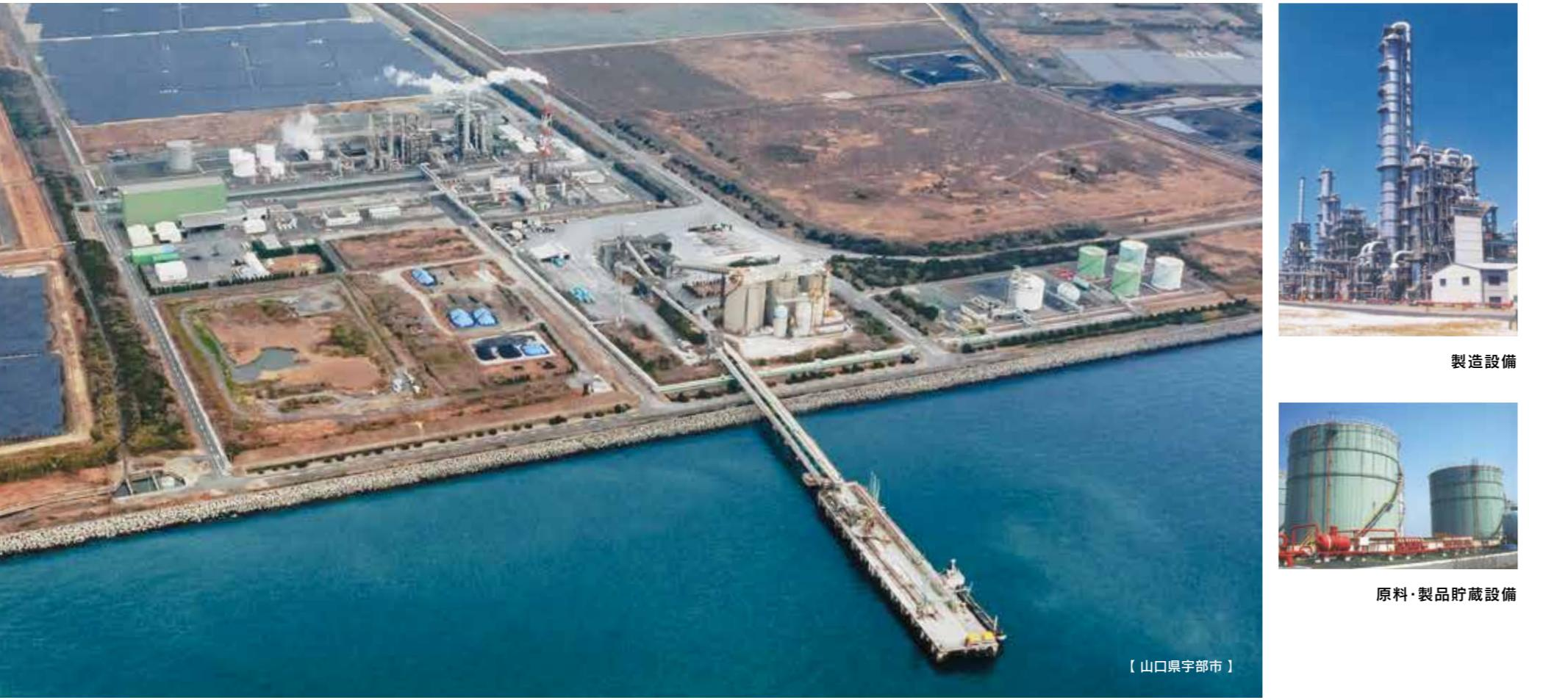
山口事業所は、一系列としては国内最大級の生産を誇るスチレンモノマープラントです。原料であるベンゼンとエチレンを反応させ、エチルベンゼンを製造。製造されたエチルベンゼンを脱水素反応させ、高品質のスチレンモノマーを製造しています。高度な技術を駆使して、徹底的な自動化を図ることで少人数による効率運転を実現しています。
