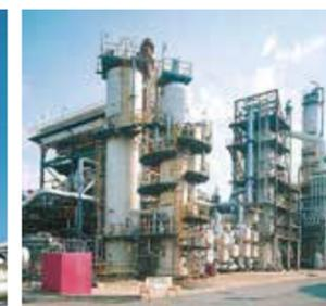
残油流動接触分解装置
