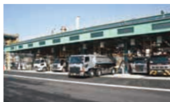
四国事業所 陸上出荷設備
