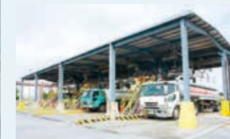
石油製品は、陸上出荷設備にてタンクローリーに積み込まれ、本島各地への安定供給をしております。
