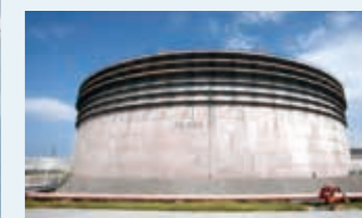
石油製品を貯蔵する大型タンクを所有し、沖縄県全域の需要に十分に対応できる量の石油製品を保管することが可能です。
