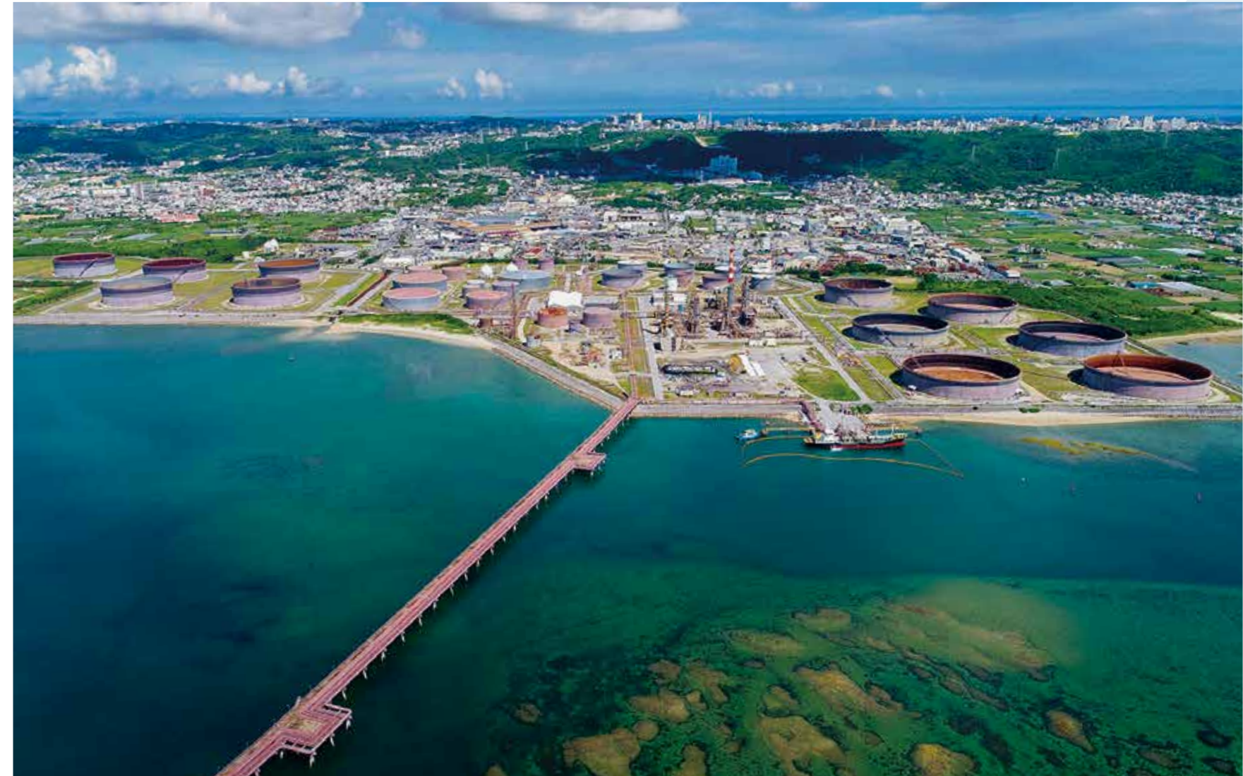
大型タンカーから小型タンカーまで着岸可能な棧橋にて石油製品を製品タンクへ受け入れます。海上出荷機能を持つ棧橋も所有し、県内離島への出荷も担っております。
