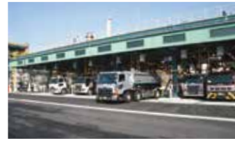
四国事業所 陸上出荷設備
