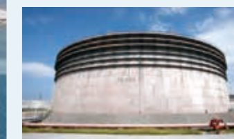
石油製品を貯蔵する大型タンクを所有し、沖縄県全域の需要に十分に対応できる量の石油製品を保管することが可能です。
