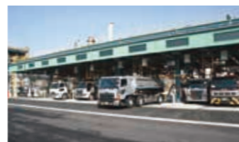
四国事業所 陸上出荷設備
