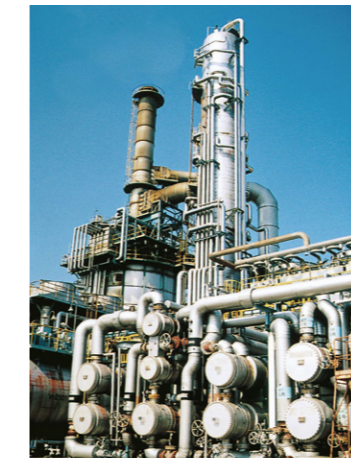
常圧蒸留装置
