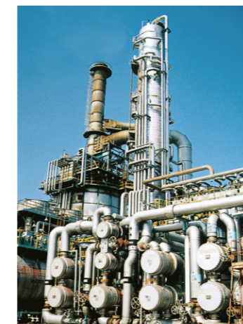
常圧蒸留装置 原油を蒸留し、LPG・ナフサ・灯油・軽油・残渣油の各留分に分離します。
