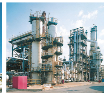
水素化分解装置 減圧蒸留装置で残渣油から分離された減圧軽油を、水素ガスと混合し、高温高圧雰囲気中で触媒と反応させ、高品質のナフサ・灯油・軽油を製造します。
