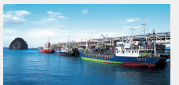
四国事業所 海上受入・出荷設備
