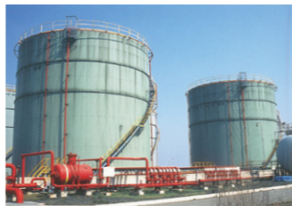
原料・製品貯蔵設備
