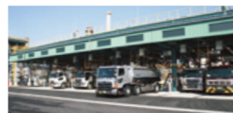
四国事業所 陸上出荷設備
